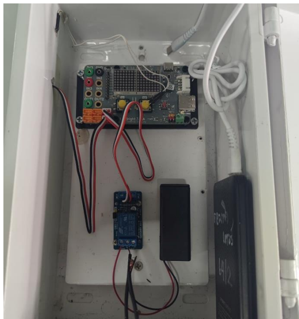
รูปภาพที่ 18 อุปกรณ์โรงเรือนเพาะเห็ด
