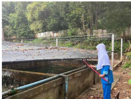
ภาพที่ ๔ กวาดเศษใบไม้บนหลังคาบ่อเลี้ยงปลา
